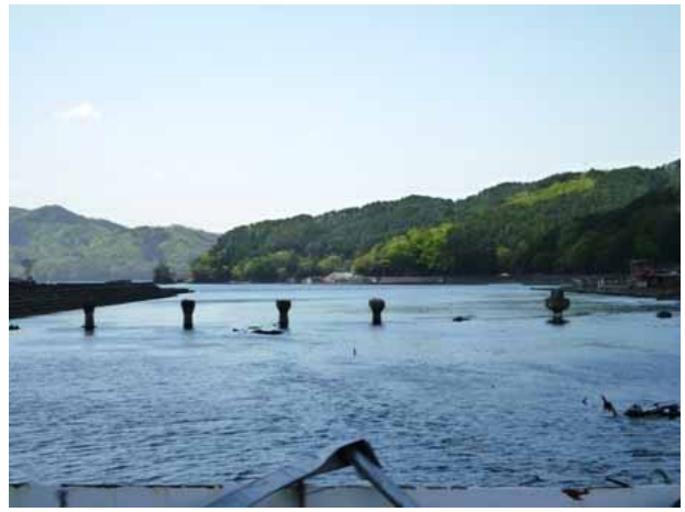
J R 山田線の流出した橋げた( <左>浪板海岸駅近く / <右>大槌町役場近く (大槌川鉄橋) ) 【大槌町】 (撮影：今瀬政司、2011年5月14日)
