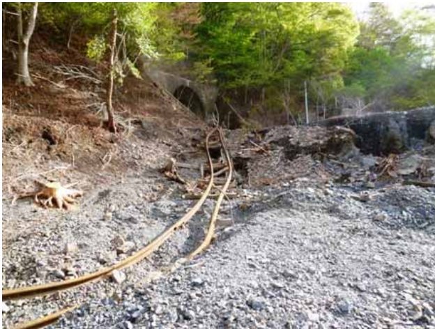
三陸鉄道 北リアス線の津波で曲がりくねった線路 (田野畑駅と島越駅の間辺り)【田野畑村】 (撮影:今瀬政司、2011年5月14日)
