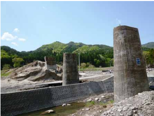
J R 山田線の流出した橋げた( <左>浪板海岸駅近く / <右>大槌町役場近く (大槌川鉄橋) ) 【大槌町】 (撮影：今瀬政司、2011年5月14日)
