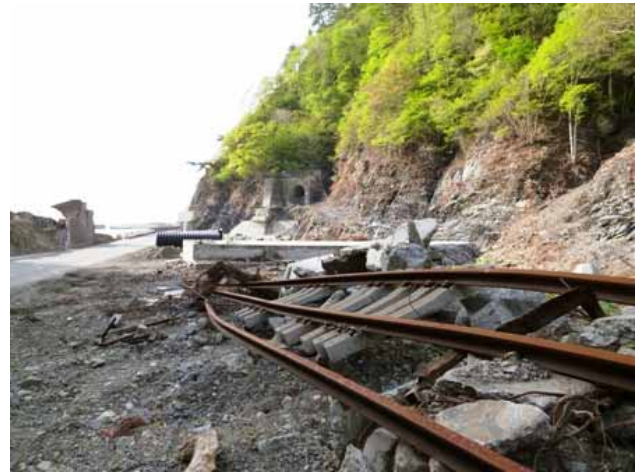
三陸鉄道 北リアス線の津波で曲がりくねった線路 (田野畑駅と島越駅の間辺り)【田野畑村】 (撮影:今瀬政司、2011年5月14日)
